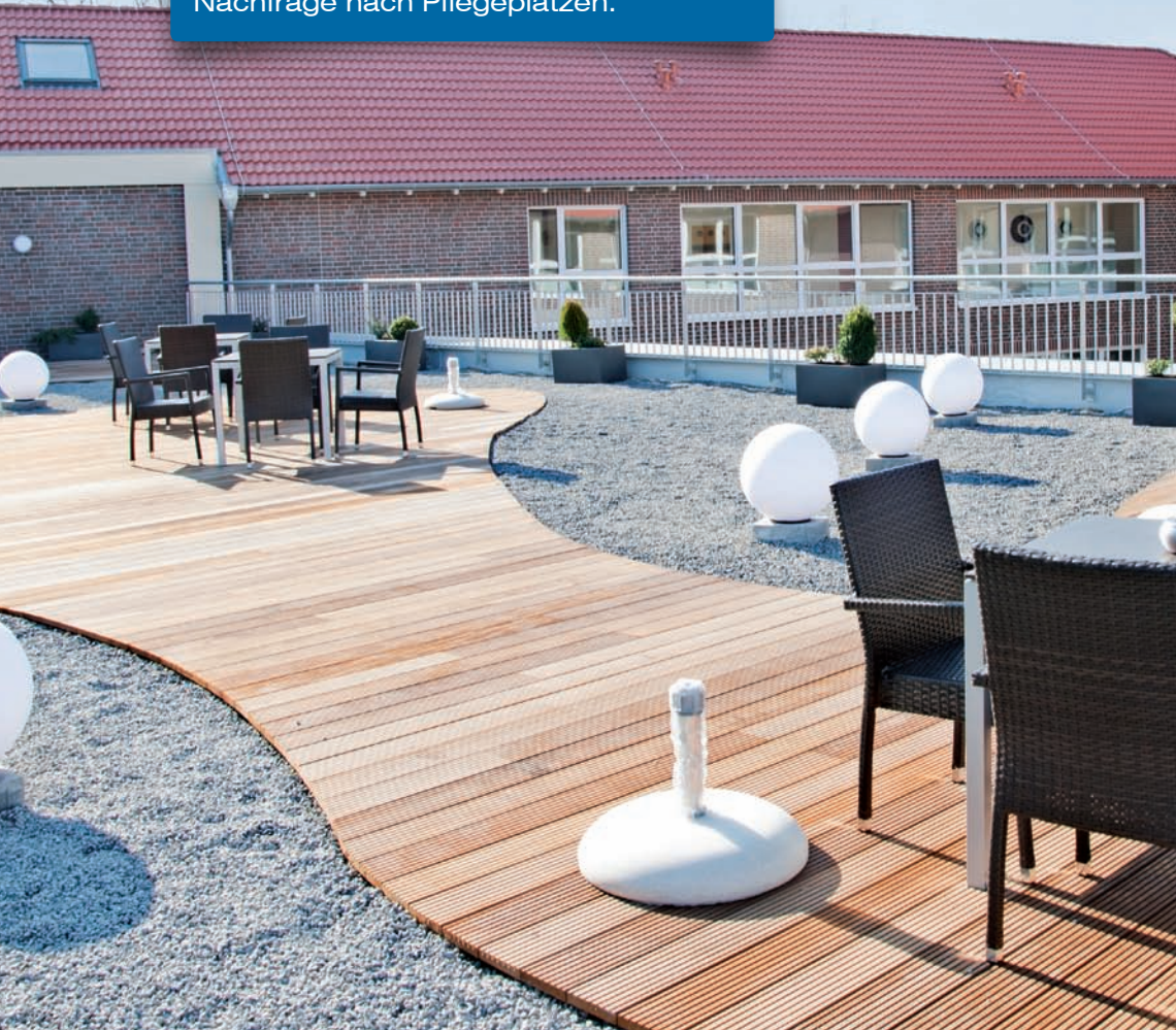
Dachterrasse des Seniorenzentrums „Am alten Hasetor“ in Haselünne
